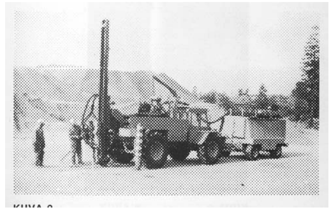
Kuva 2. Tutkimuskairausta raskaalla porakonekairausyksiköllä.
