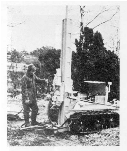
Kuva 1. Porakonekairausta hydraulisella monitoimikairalla.
