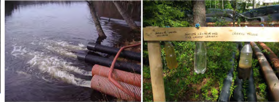
Kuva 24 ja 25. Geotuubi-käsittelyssä poistuva vesi palautettiin järveen. Palautuva vesi oli kirkkaampaa kuin järvestä otettu luonnontilainen vesinäyte.
