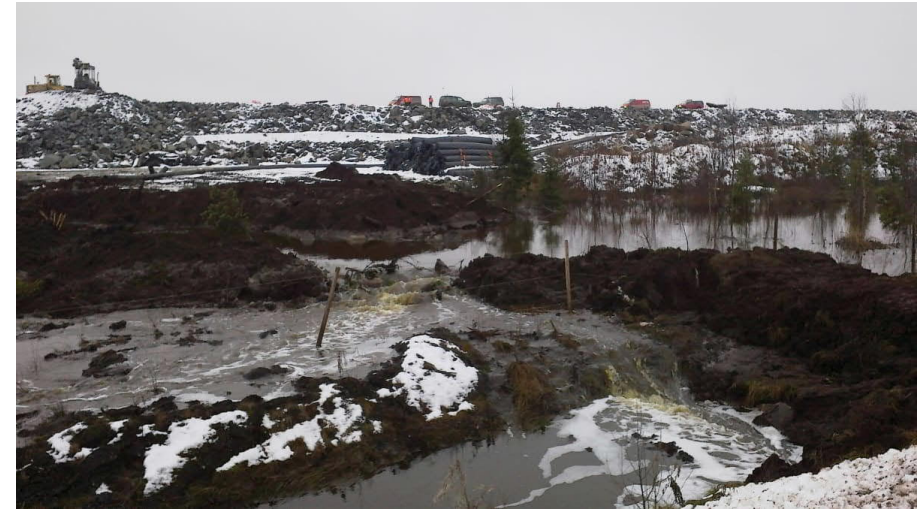
Talvivaaran kaivoksen kipsisakka-altaan vuoto vuonna 2012. Kuva: Yle
