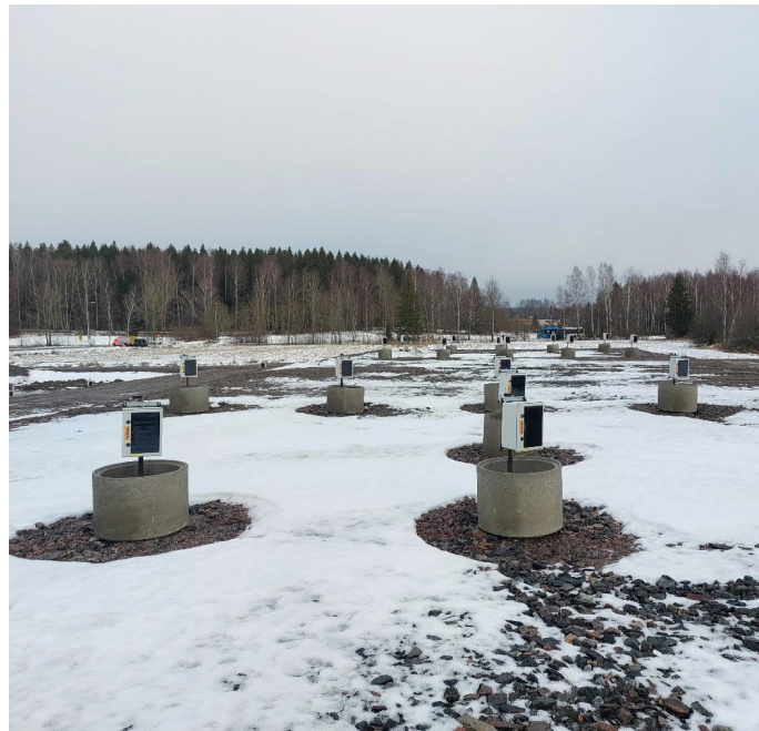
Penger valmis, painumalevyjen tankoihin asennettu GNSS-mittausyksiköt
