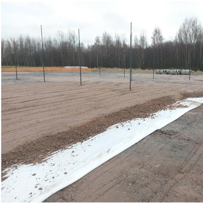
Painumalevyt juuri asennettuina
