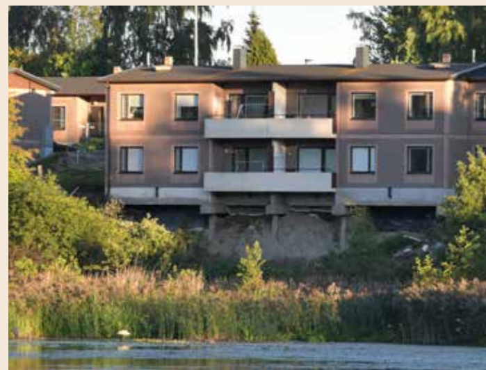
◀ Kuva 1: Asunto-osaakeyhtiön Kaarilankulman rivitalo vaarassa sortua Tampereella KUIVA: Simo Laitakari
